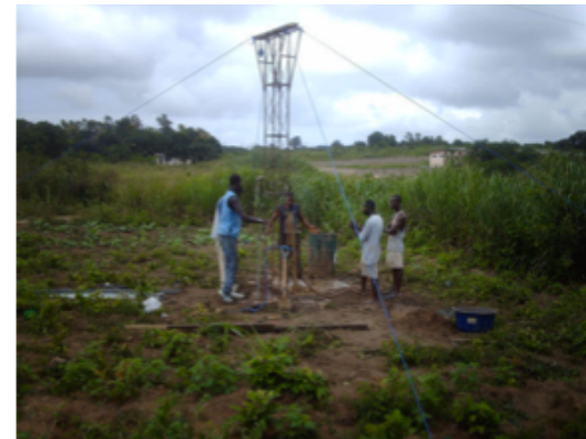
Für das System von Martin Wobken (siehe links unten) genügen 3/4-Zoll-Rohre, die auch in ländlichen Gebieten Afrikas erhältlich sind.
